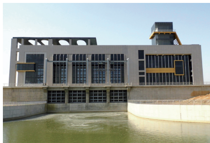
(c) 八里湾泵站
