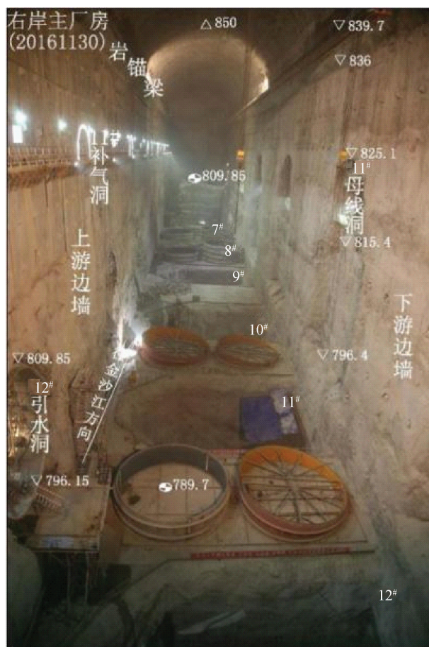
图 1 某电站地下厂房开挖衬砌后影像
