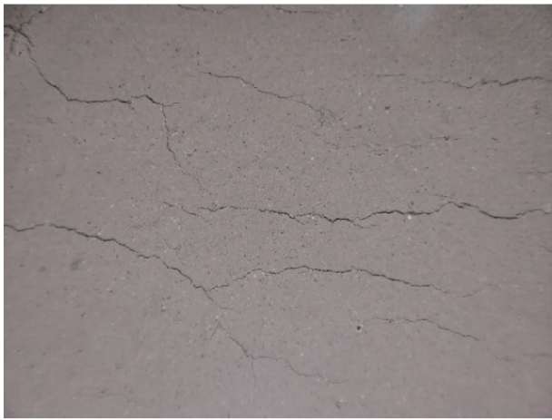
(a) 赤泥干缩产生裂缝
