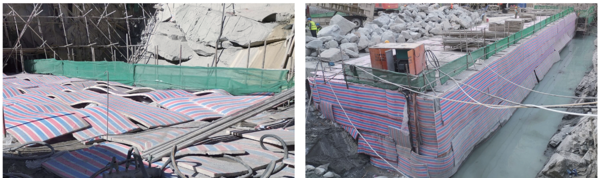
(a) 施工仓面的保温措施
