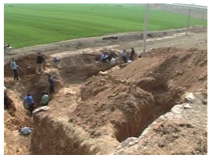
图 3 坝坡蚁道开挖现场
