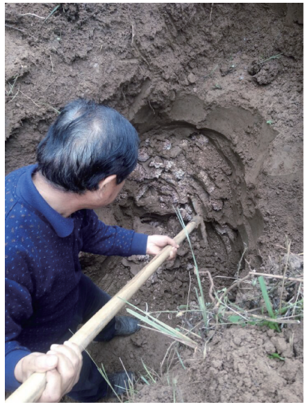
图 1 坝坡蚁巢开挖现场
