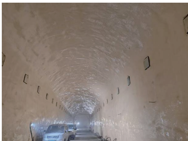
图 12 防水抑氡结构完成效果
