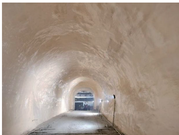
图 12 防水抑氡结构完成效果
