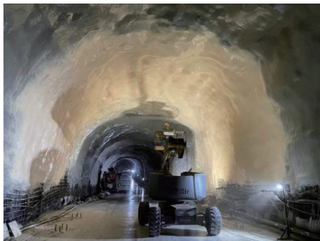
图10 砂浆、聚氨酯胶泥、面漆/清漆施工
