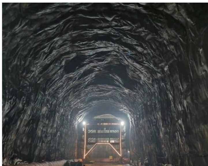
图 7 3 mm 厚速凝橡胶喷涂辅助隧道(左)和实验大厅(右)
