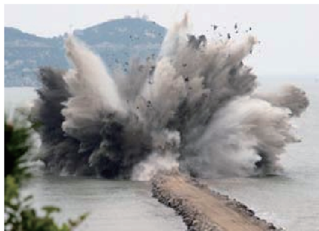
图2 爆破挤淤抛填石替换淤泥
