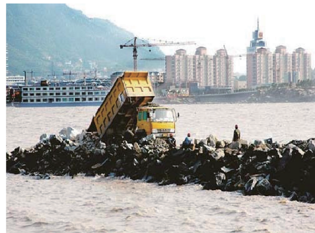
图2 爆破挤淤抛填石替换淤泥
