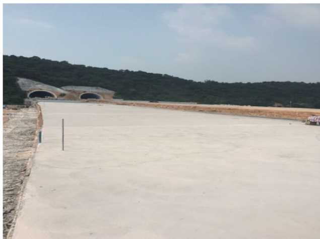
图1 现浇泡沫轻质土路基填筑
