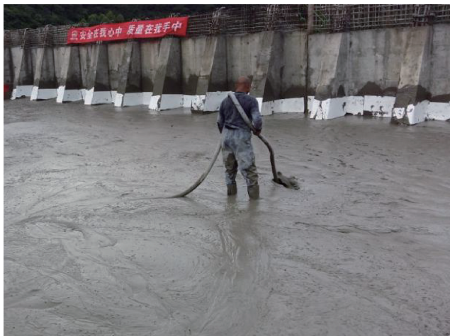
图1 现浇泡沫轻质土路基填筑
