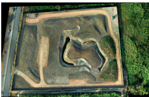
6th Month: Earthwork completion 第6个月：土方工程完工
