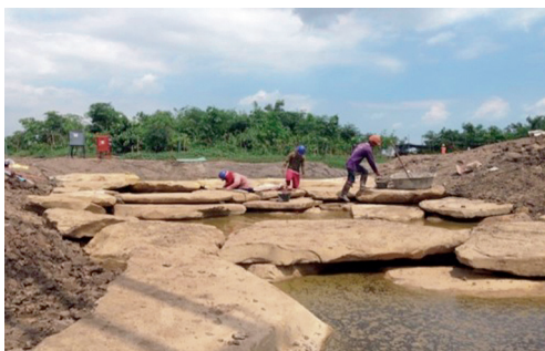
32nd Month: Stone terrace work 第32个月：石阶铺设
