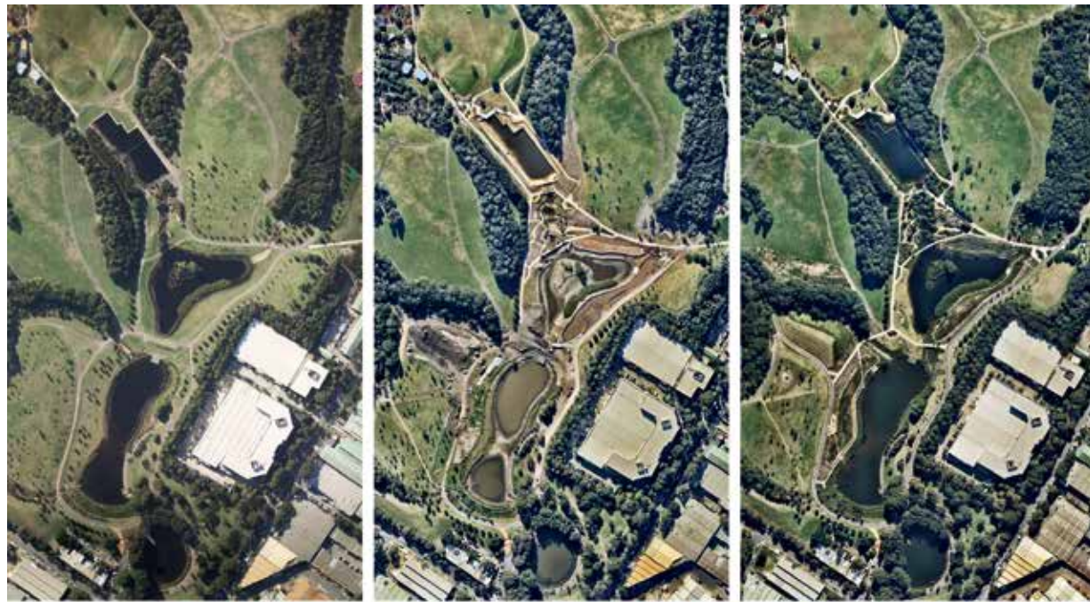
改造前 2013年4月 Before Construction April 2013
