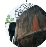
水塔 Water tower
