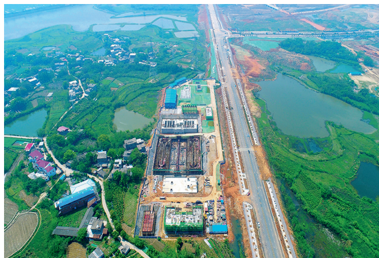
1. 建设中的江西省九江市芳兰污水处理厂一期工程
