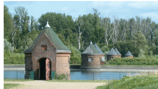
废弃砂滤池和修复的滑块建筑
