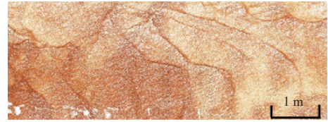
图10 管道裂隙在点云数据中的表征
