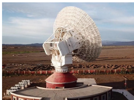
图7 喀什深空站35 m测控设备
