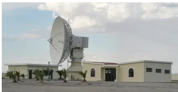
图 16 纳米比亚站18 m S/X双频段测控设备 Fig. 16 18 m S/X band TT&C equipment of Namibia station
