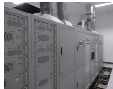
(b) X频段发射机
