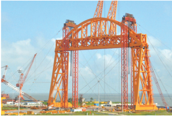
Fig. 1 22000-ton gantry crane.
